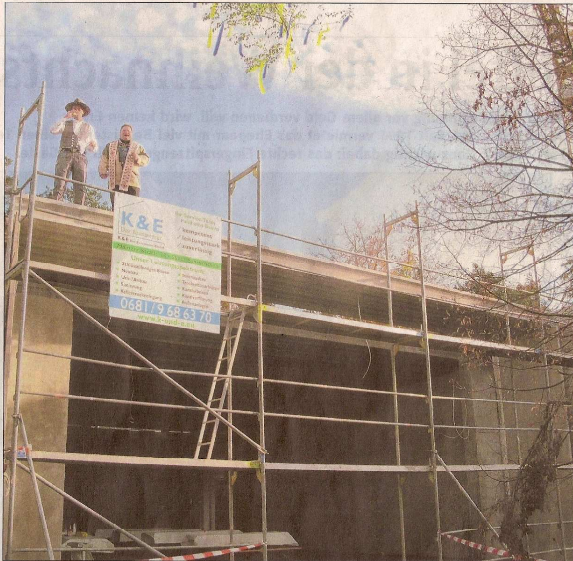
Es wird Richtfest gefeiert: Geschäftsführer Uwe Erhard von der Firma K & E formulierte einen Richtspruch, bevor Pfarrer Matthias Leineweber den entstehenden Gemeindesaal von St. Fronleichnam segnete. FOTO: GIW
